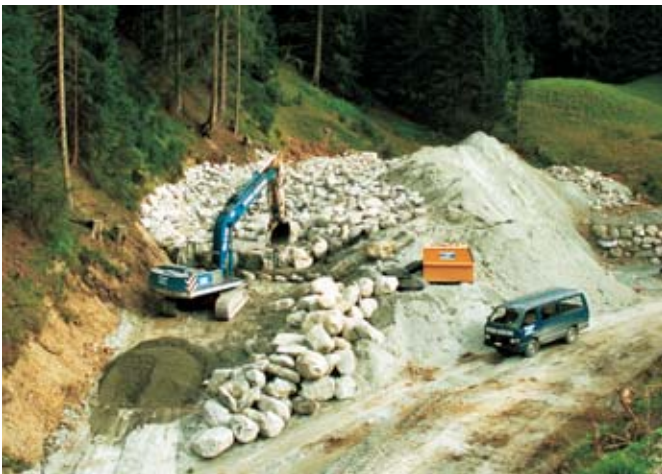
Die aufwändige Gerinnesicherung im Mittellauf
