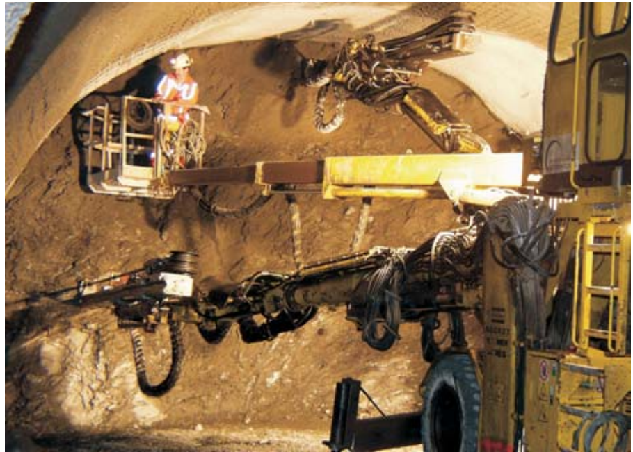
An der Tunnelbrust des Sprengvortriebs
