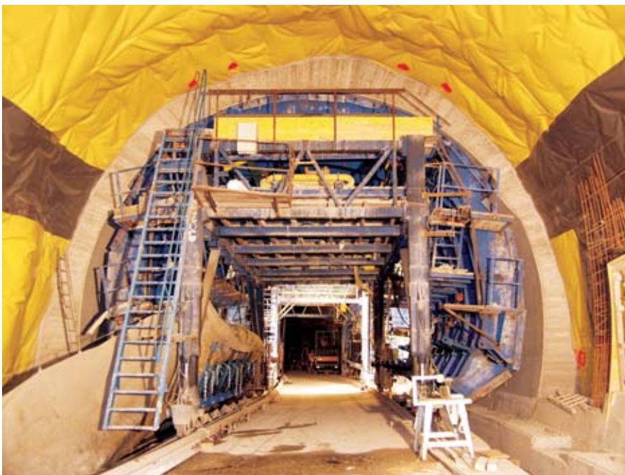
Betonieren des Innenrings des 4207 Meter langen Gotschnatunnels
