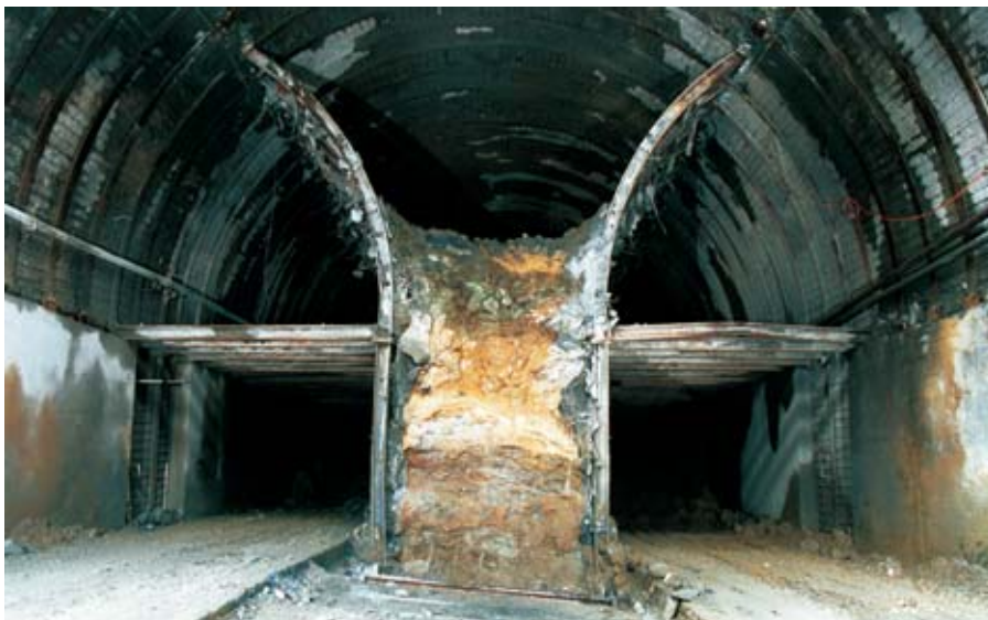
Deutsche Kernbauweise im fallenden Vortrieb von Selfranga. Der weitgehend kakiritisierte Fels im Kern wird wie ein Lockergestein mit dem Abbauhammer gelöst
