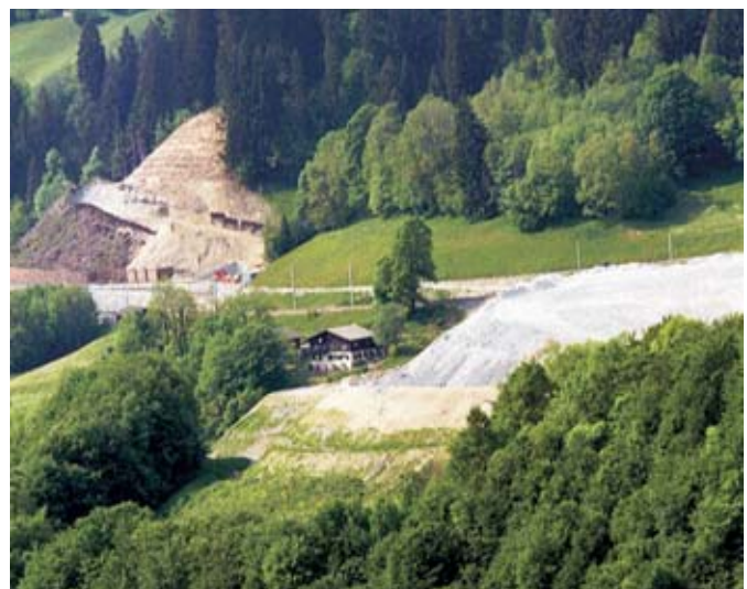
Die Böschungswinkel der Schüttung Büel sind der Umgebung angepasst, der Waldrand ist "natürlich" unregelmässig ausgebildet
