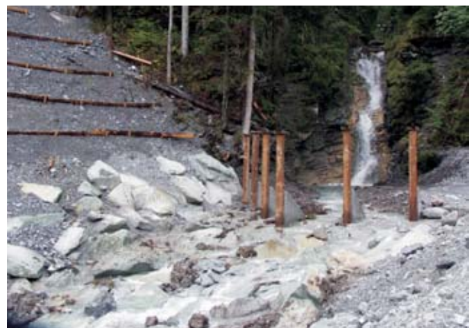
Die Umleitung des Drostobelbaches in sein neues Gerinnes
